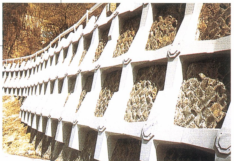
石積み擁壁補強工事 (山梨県)
